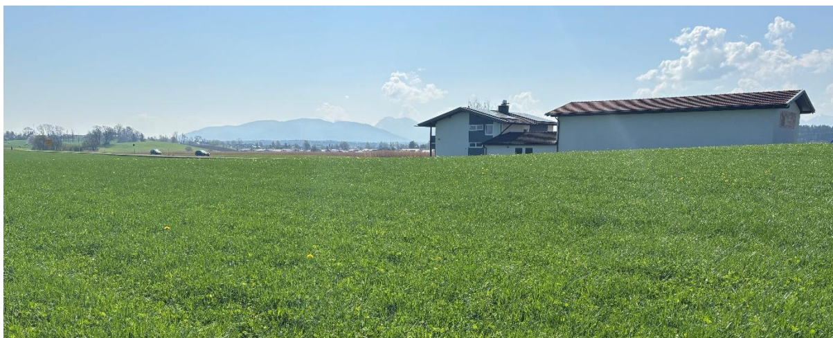
Abb. 8 Blick von Norden nach Süden auf den Gebäudebestand im Plangebiet
