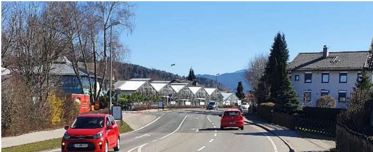
Abbildung 6: Hochstraße (St 2105) mit Linksabbiegespur zum heutigen Parkplatz/ geplanten BV (Foto PSLV 23.03.2022)
