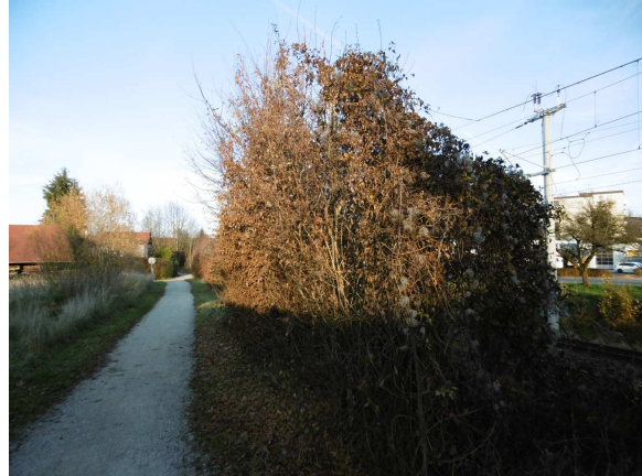
Abb. 2 Bahntrasse mit Geh- und Radweg
