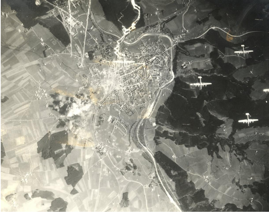
Luftangriff auf das Umspannwerk der Bahn an der Wegscheid am 25. April 1945
